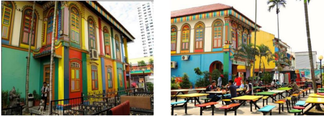
Gambar 6. Bangunan disekitar Little India yang berada di Singapura
